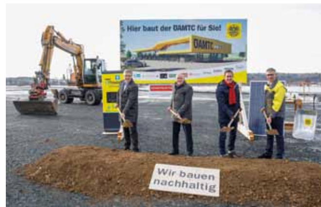
Im Industriegebiet Nord entsteht der neue Stützpunkt des ÖAMTC. Nachhaltige Bauweise spielt dabei eine wichtige Rolle.
